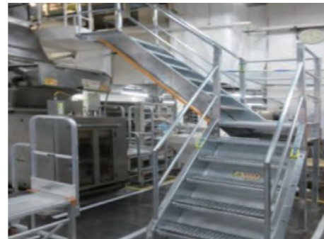
梯子から階段への設備改善(新潟工場)
