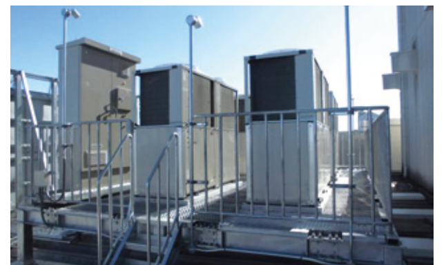
CO 2 冷媒冷凍機（安城冷生地事業所）
