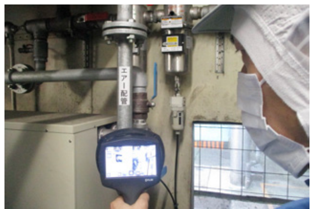
音響カメラを使用したエアリーク点検の様子
