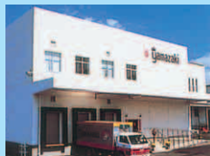
香港ヤマザキ大埔工場 香港山崎麵館有限公司 HONG KONG YAMAZAKI BAKING CO., LTD. TAI PO FACTORY
