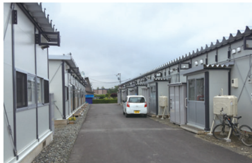
空調機設置を支援する仮設住宅 (北海道厚真町)
